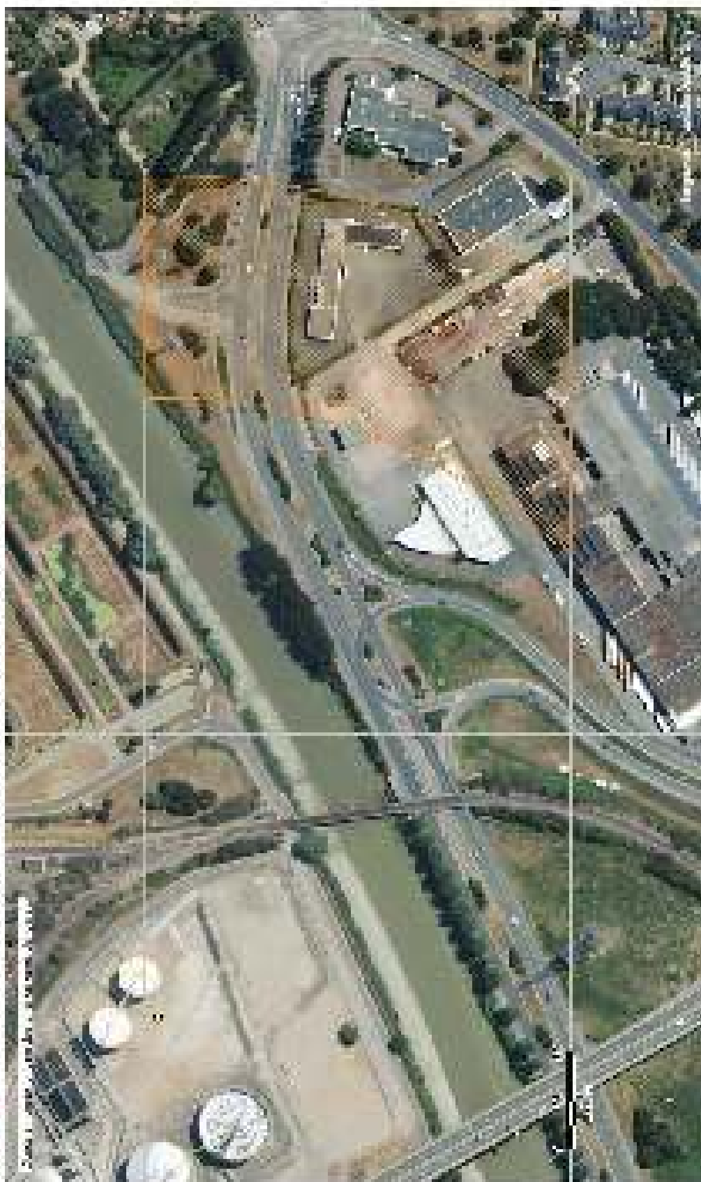
PART DE MONDEVILLE (DPC) Ouvrage de dérivation de l'axe n° 31 (Haut 4 - Déclivité n° 21 - 80 mbar)
