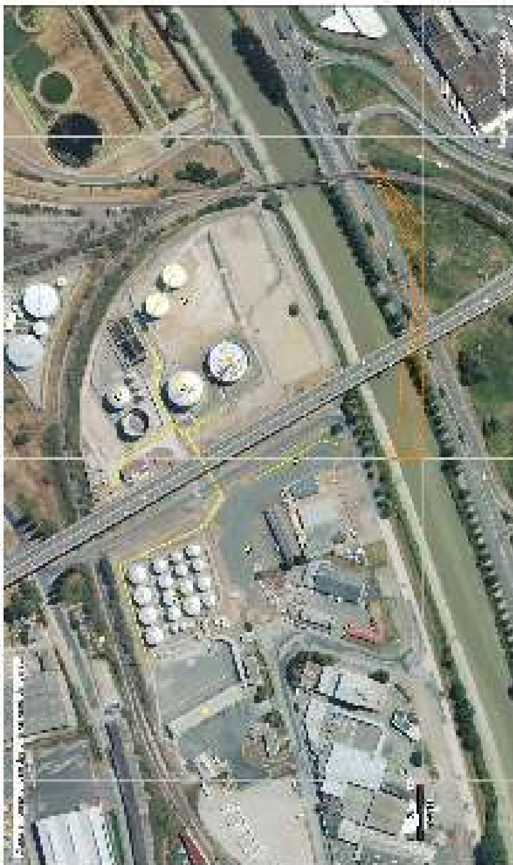
PART DE MONDEVILLE (DPC) Ordonnance de Prévention des Risques de Technologie n° 26 (Haut) 2 - Ordonnance de Prévention des Risques de Technologie n° 26 (Haut) 2 - Ordonnance de Prévention des Risques de Technologie n° 26 (Haut) 2
