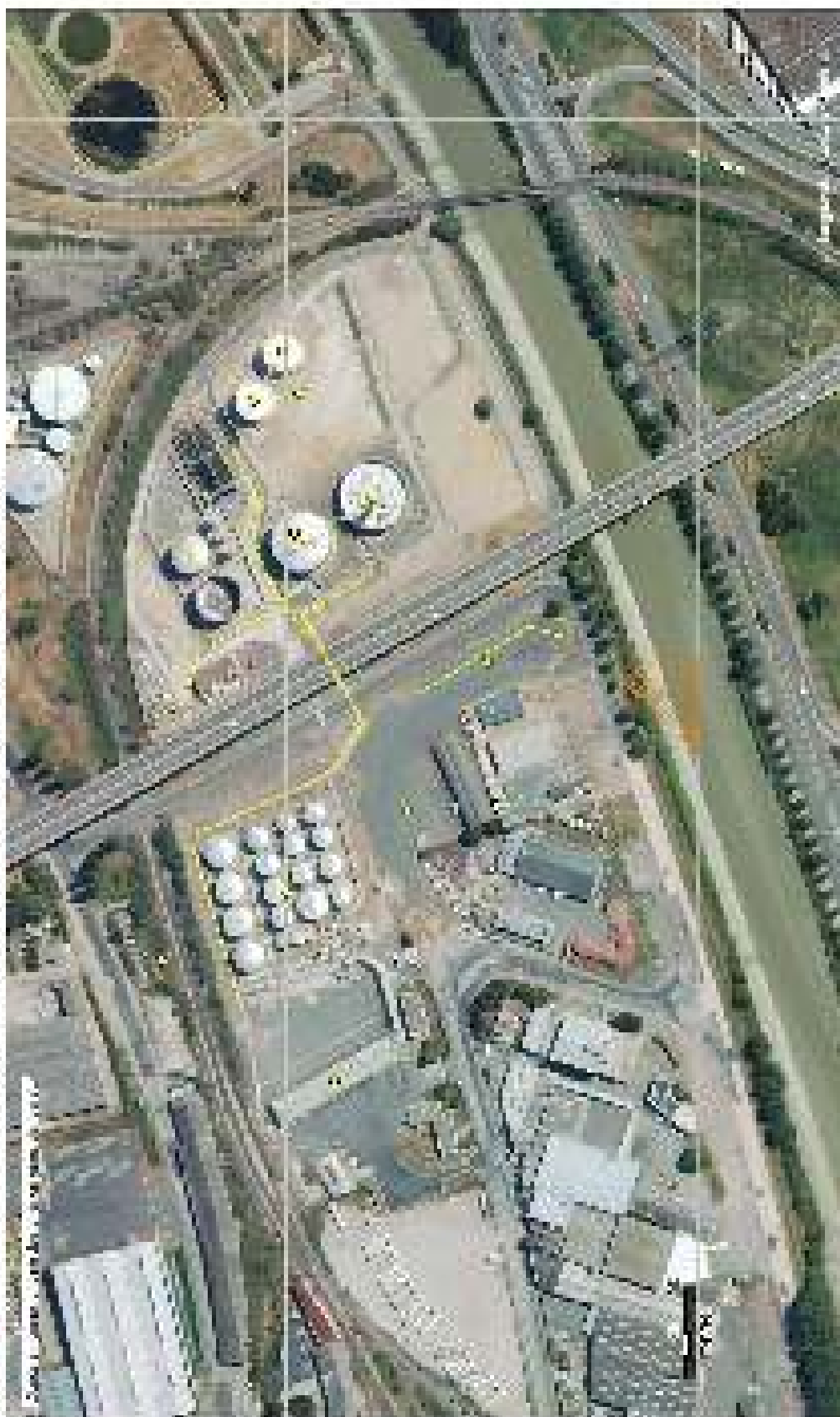
PART DE MONDEVILLE (DPC) Ouvrage de traitement des effluents n° 25 (Hang 2 - Oude de afrot. 20 - 31 m³/s)
