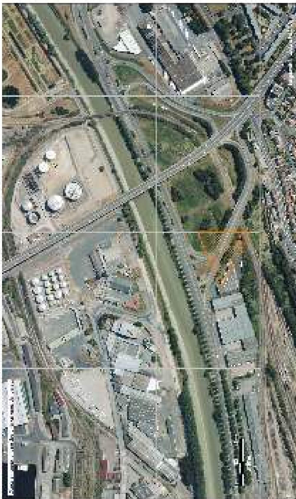
PART DE MONDEVILLE (DPC) Ouvrage de dérivation de l'axe n° 37 (Haut 4 - Déclivité 21 - 80 mBar)
